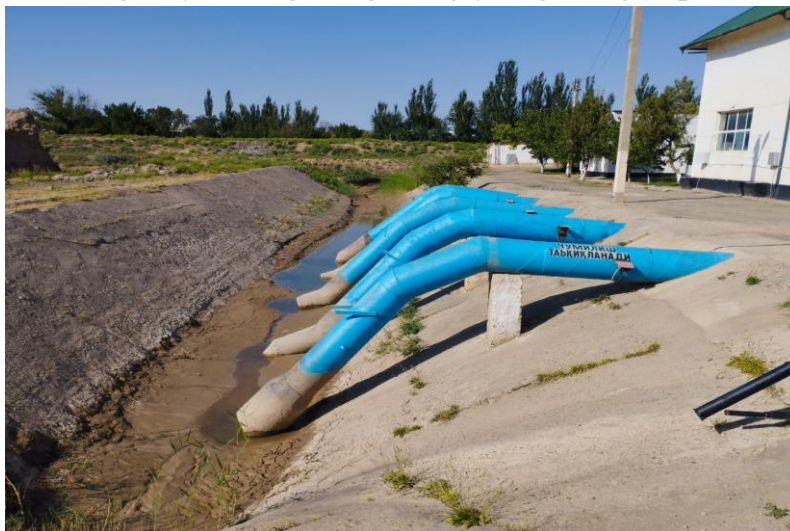
1.3- rasm. Nasos stansiya so'rish quvurining holati.
